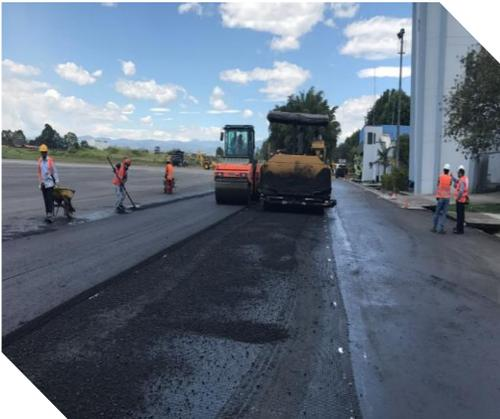
Se consideró la inclusión de una geomalla de fibra de vidrio R100 de 100 kN/m<sup>2</sup> de resistencia en ambos sentidos, con el fin de reforzar la carpeta asfáltica a instalar en la zona de plataforma y calle de rodaje, incrementar la resistencia a la fatiga, retardar la aparición y reflejo de las fisuras existentes.
