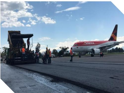
Se instalaron mas de 10.000m<sup>2</sup> de geomalla fibra de vidrio, lo cual garantiza la minimización de patologías sobre la carpeta asfáltica del área intervenida y retarda el tiempo de intervención para su mantenimiento.
