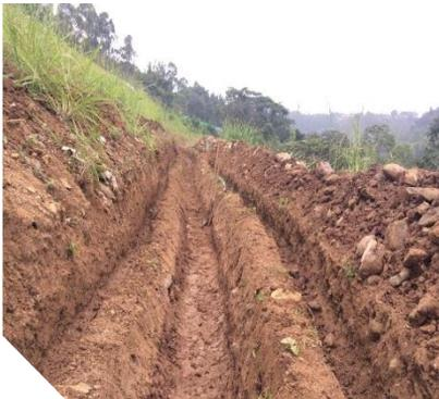
Para controlar las aguas de escorrentía y evitar que éstas se infiltren en el ZODME, se construyeron cunetas o zanjas de coronación en el desarrollo de la estructura, éstas cunetas son flexibles puesto que se construyen con geomembrana de alta densidad, las cuales pueden reemplazar a las cunetas que se realizan en concreto, ya que los ZODMES pueden sufrir grandes deformaciones y generar fracturas en el concreto por ser un material tan rígido.
