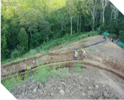
Cuando se realiza un proyecto de gran magnitud, como es la ampliación de la doble calzada Ibagué Cajamarca, se deben construir zonas de manejo de escombros y materiales de excavación (ZODME), éstas estructuras deben tener un muy buen manejo de las aguas superficiales, evitando que las aguas de escorrentía alcancen altas velocidades y generen inestabilidad y socavación.
