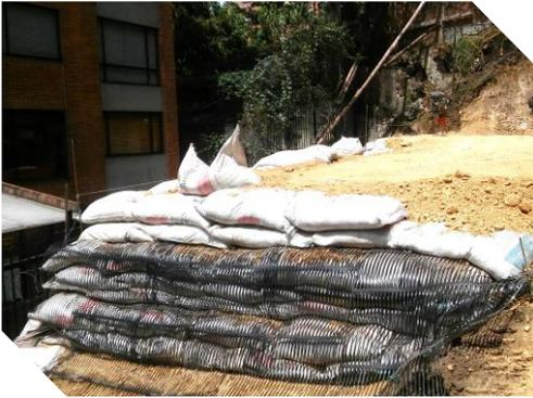
Debido a la arquitectura del parque, se diseñó un muro de contención que pudiera tener una fachada verde mucho mas acorde, además, con la vista de los apartamentos del Edificio Mandarin. Fue así como se construyó un Muro en Suelo Reforzado de 8 m en terrazas con Geomalla Uniaxial Coextruida PUX-11 en capas de 50 cm y con fachada en sacos de polipropileno. Se instaló un sistema de drenaje al espaldón del muro y lloraderos intermedios con Geodren Planar.
